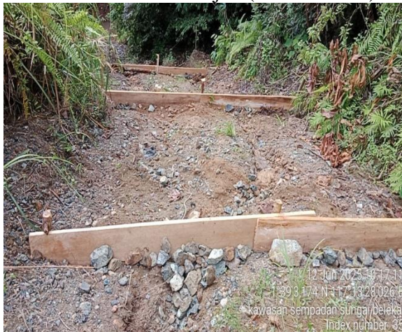
Pemasangan Sedimen Trap
