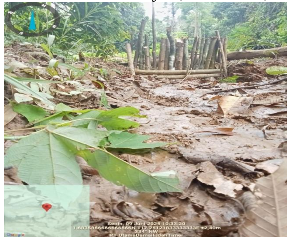
Pemasangan Sedimen Trap
