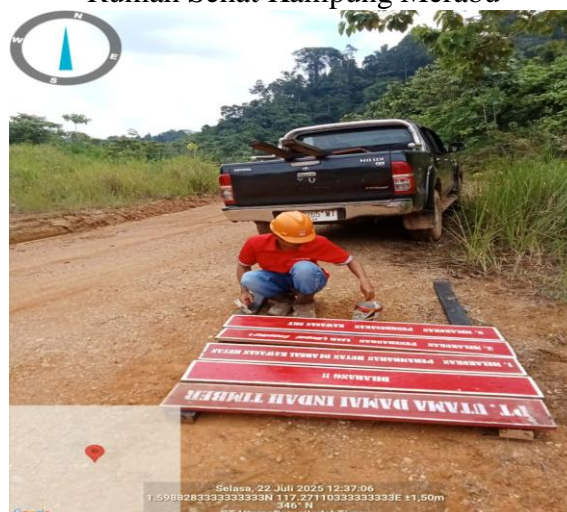
Pemasangan Plang Himbauan
